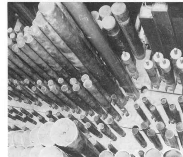
Die obere Aufnahme zeigt den mit originalen Eichenkondukten hochgeführten Cornett des Hauptwerks. Er steht dicht hinter dem Prospekt im Bereich der Zwischenfelder. Die Pfeifen von c' wurden später zugefügt und alle übrigen entsprechend aufgerückt. Bei der Restauration wurden alle Pfeifen der Orgel mit selbstklebenden Papierstreifen beschriftet, um Verwechslungen der nur schwach original signierten Pfeifen auszuschließen.
